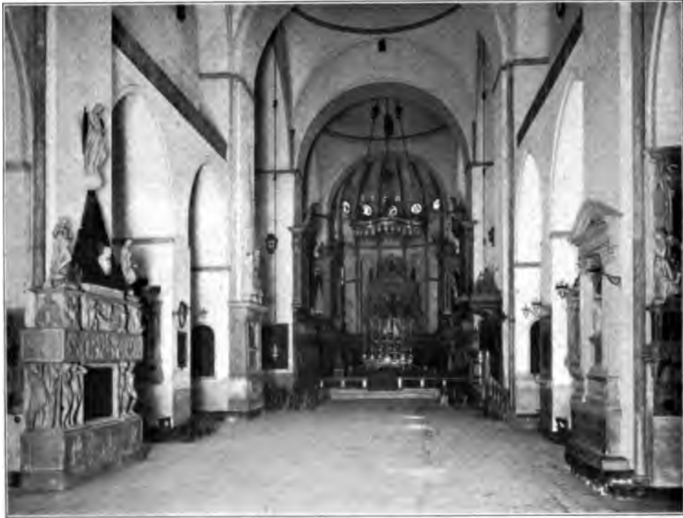
Vue intérieure de la Basilique de Saint-Antoine.
